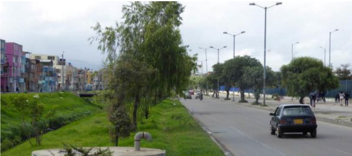
Figura 6.26 Vista del canal Tintal II a la altura del recinto del Portal de las Américas
