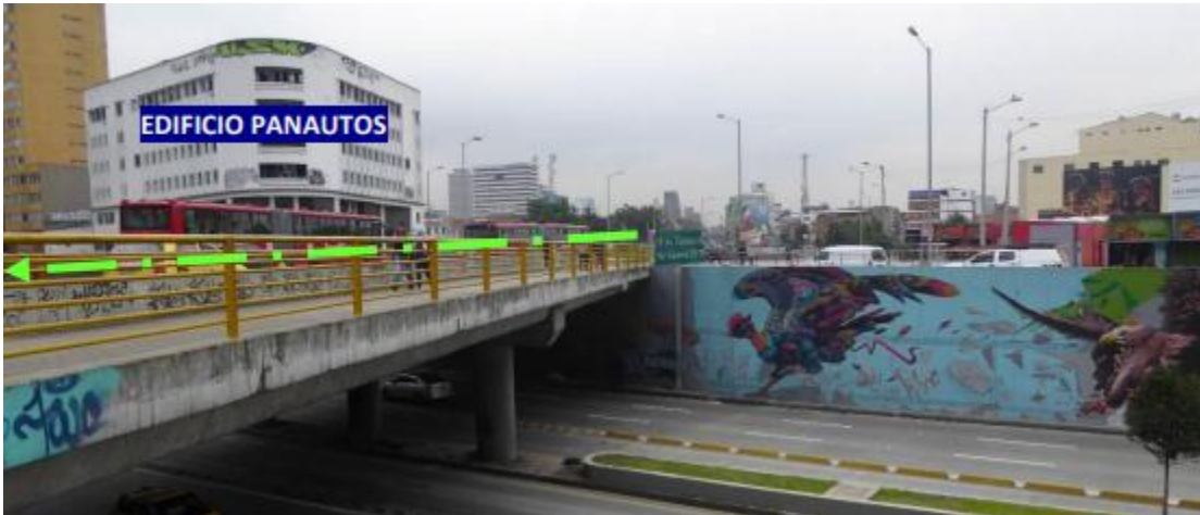
Figura 6.54 Vista del paso de la Av. Caracas sobre la Calle 26
