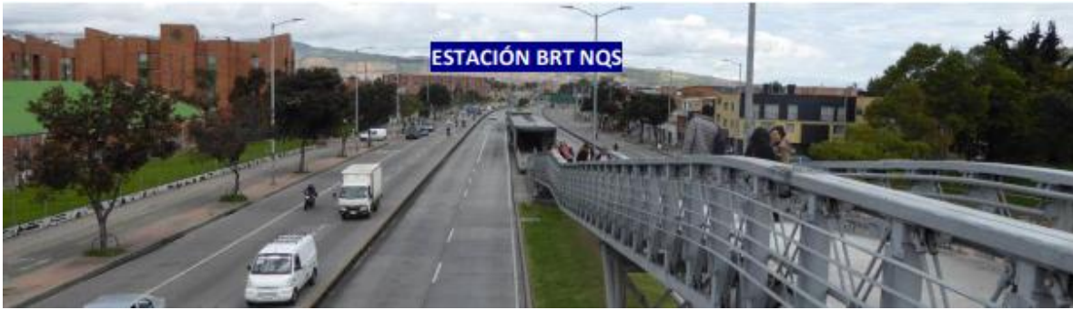
Figura 6.42 Vista de la estación de Transmilenio NQS
